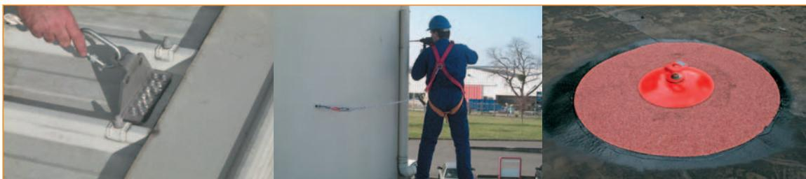
Les crochets pour échelle de couvreur **SÉCURIT 2005** permettent l'accès aux toitures traditionnelles tout en sécurisant le travailleur.
